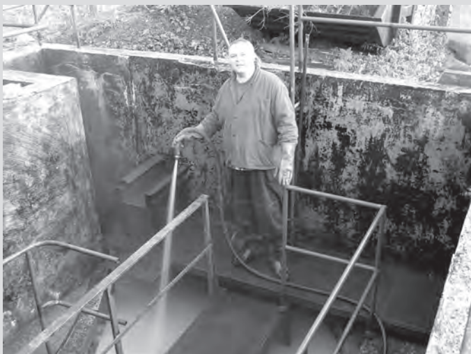
Na dnes již historickém snímku provádí pracovník městské čistírny odpadních vod Josef Cmaro údržbu šnekových dopravníků, které byly v rámci akce Čistá řeka Bečva nahrazeny novým zařízením
