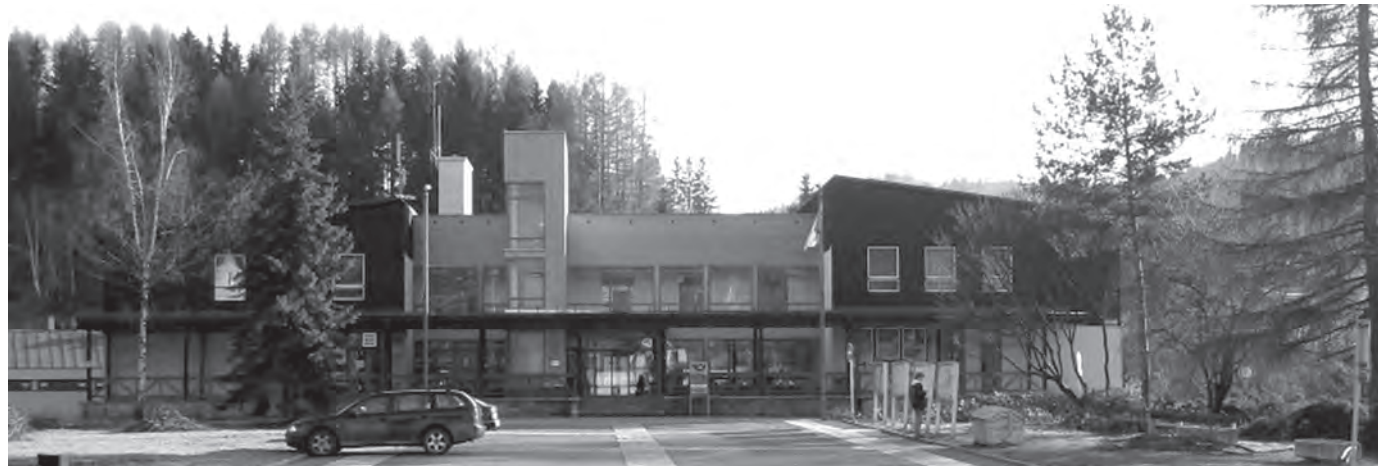
Nový pohled na budovu městského úřadu po rekonstrukci vstupu a přístavbě výtahu.
