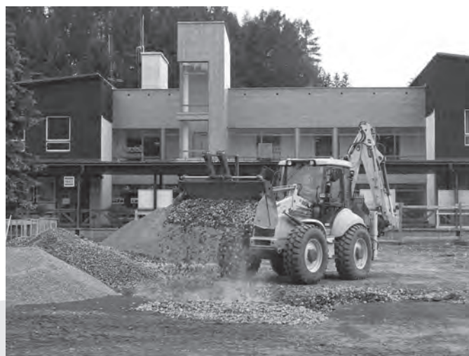
Plochu před městským úřadem v rámci rekonstrukce náměstí v současné době obsadily stavební stroje
