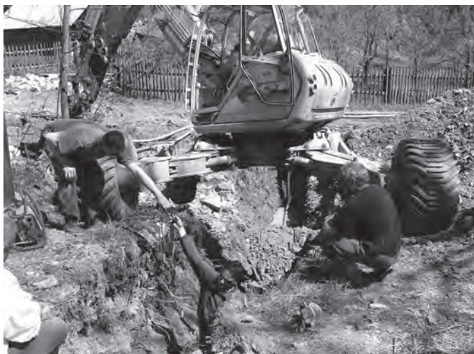
Na snímku vidíte pracovníky městského bytového podniku Pavla Střeleckého a Petra Dujku při provádění náročné přeložky vodovodu pod Ratkovským potokem
