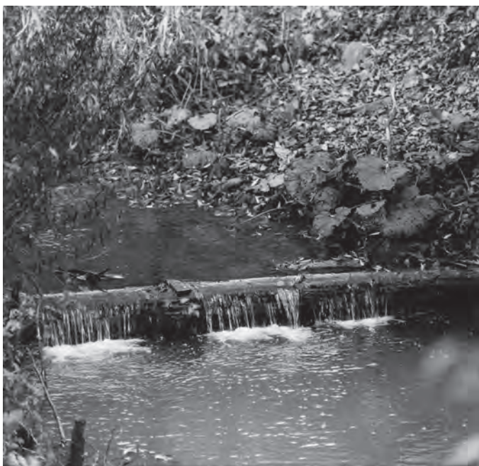
Takhle to na Valašsku bývalo zvykem a s nižšími náklady – splávky místo skluzy.
