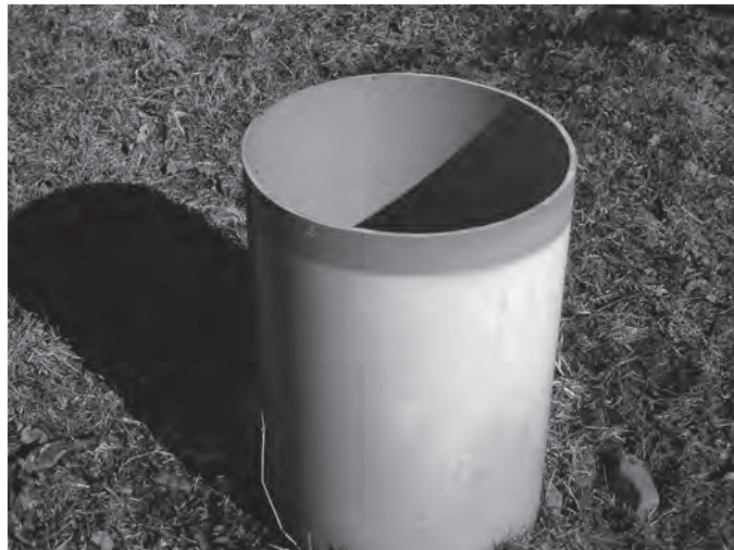
Kanalizační šachta na Okružní, na které byl ještě nedávno litinový krycí poklop. Byl.
