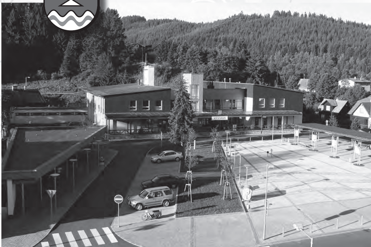
Současná podoba Radničního náměstí, stavby roku 2007 Zlínského kraje
